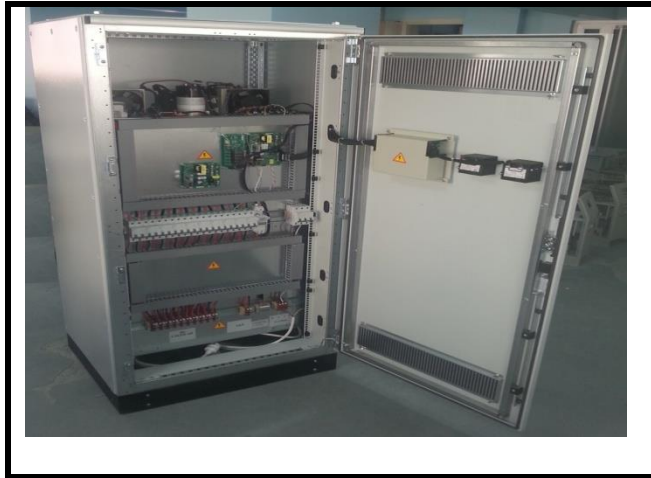
Gambar 3.9 Batre Rectifier
