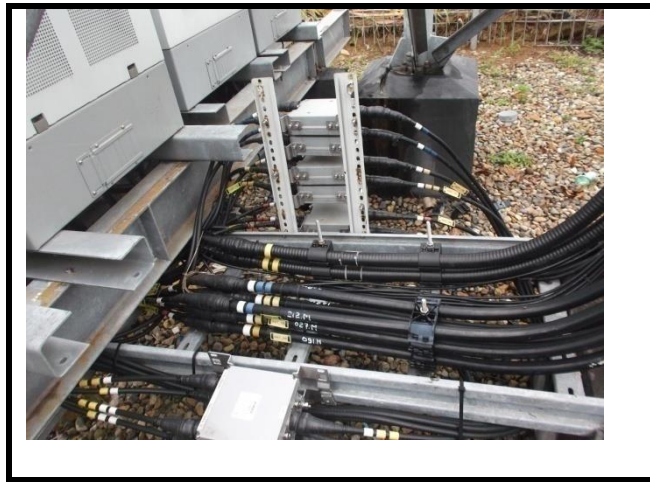
Gambar 3.12 feeder pada BTS ISP3
