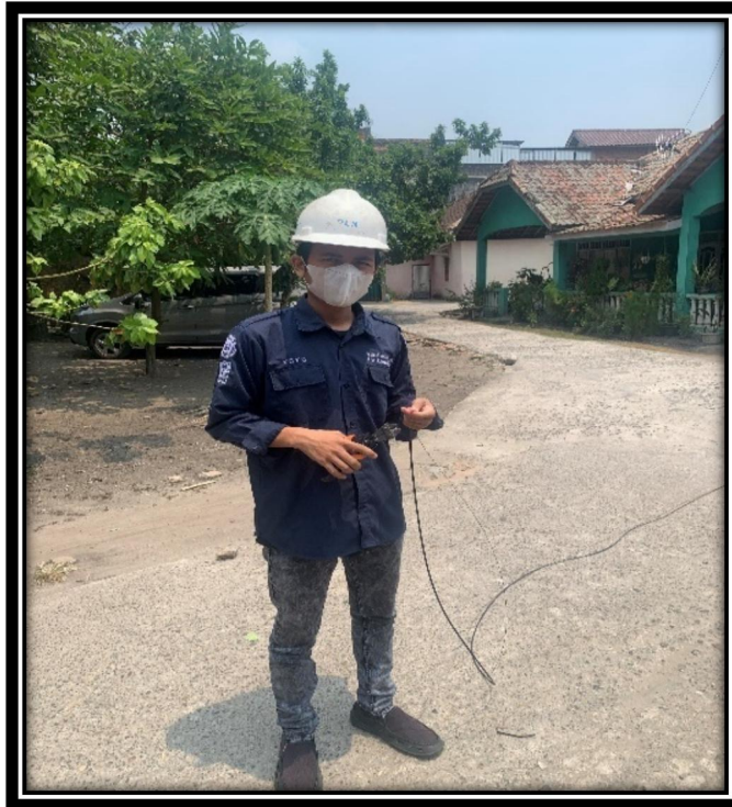
Gambar 3.10 Penurunan Kabel Fiber optic yang Putus (Sumber: Bapak Oriza Syahputra)
