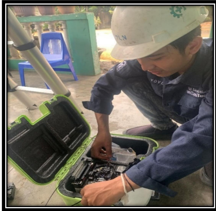
Gambar 3.11 Penyambungan dengan Splicer
